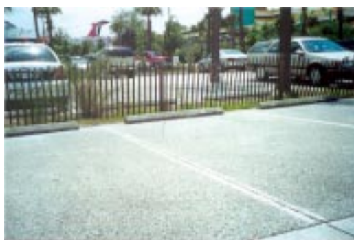
Figura 2: Ejemplo pavimento de hormigón poroso (Florida, Estados Unidos).
